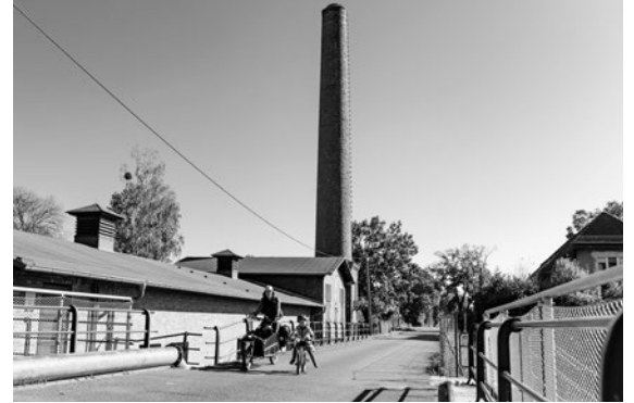
Gleich bei zwei Entdeckertouren im Oderbruch, in und um Oderberg und Altranft, kann man das Schöpfwerk Neutornow besichtigen.
