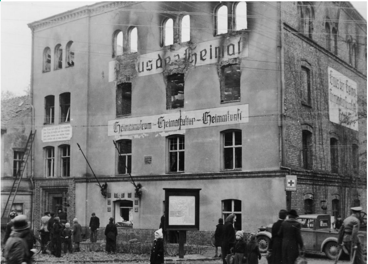
Weihnachten 1943 wurde das „Haus der Heimat“ in Woltersdorf durch einen zufälligen Bombentreffer zerstört.
