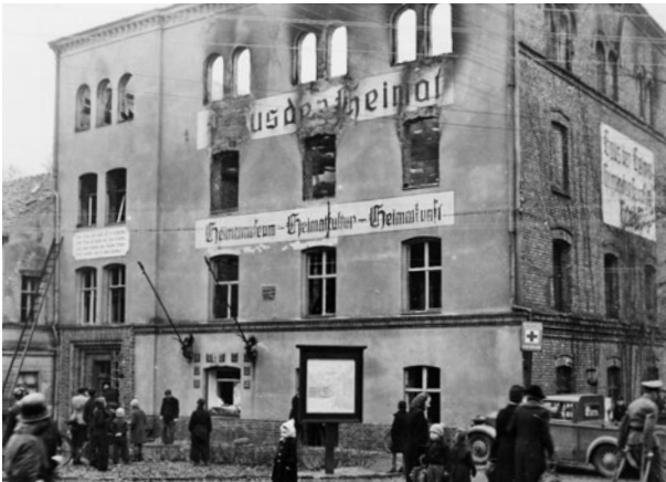
Das „Haus der Heimat“ Woltersdorf wurde am 24. Dezember 1943 durch einen zufälligen Bombentreffer zerstört (Aufnahme vom 25. Dezember 1943).
