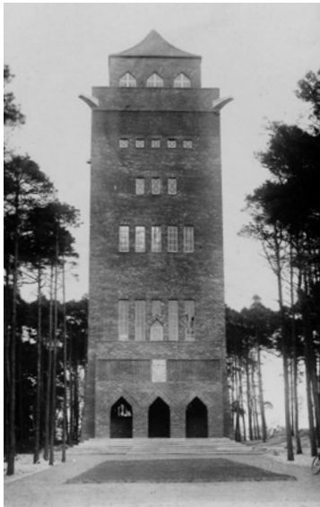
Der Beelitzer Wasserturm als Museumsgebäude, Inv. Nr. 1064.
